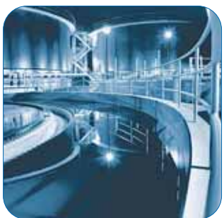
Água/Tratamento de Água
